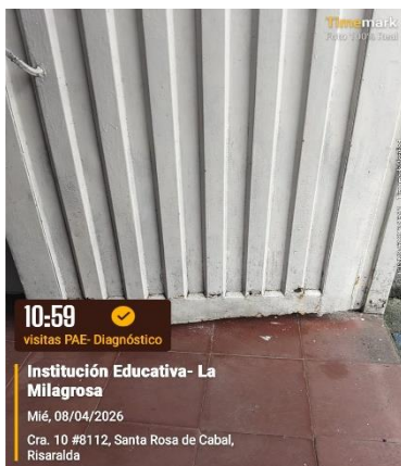
Fotografía 5: Puerta con presentan corrosión
