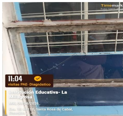
Fotografía 6: Vidrios fracturados
