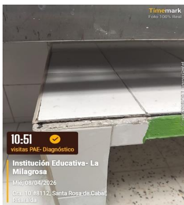
Fotografía 3: El mesón sin emboquilladura
