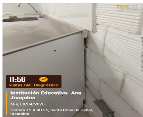
Fotografía 3: mesón inferior presentan no se realizó la emboquilladura correspondiente.
